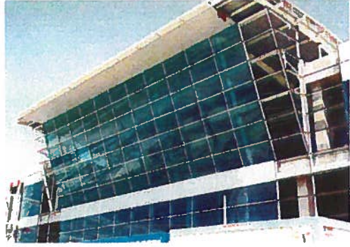
Atatürk Havalimanı Yeni Dış Hatlar Terminali IMF 170+ Dupont Azurblue PVB kombinasyonlu üniteler Camlardaki "Azur" renk , kaplama değil PVB kaynaklıdır
